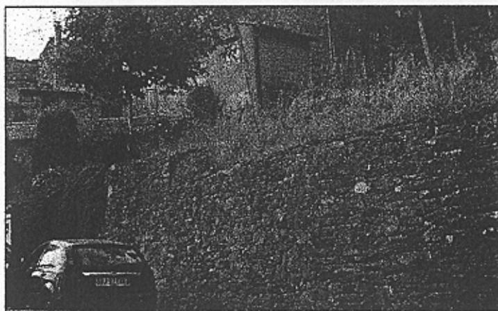
Sezione stradale con muro continuo in pietrame.
