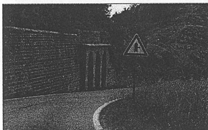
Sezione stradale con muro continuo e sostegno ad archi.
